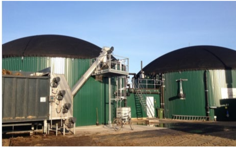
Digestor Completamente Mezclado (CSTR)
